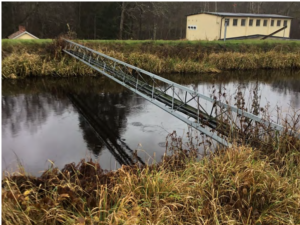
Bild 1: Vattenkorsning i norr: Almaån korsas av en fackverksbro.
