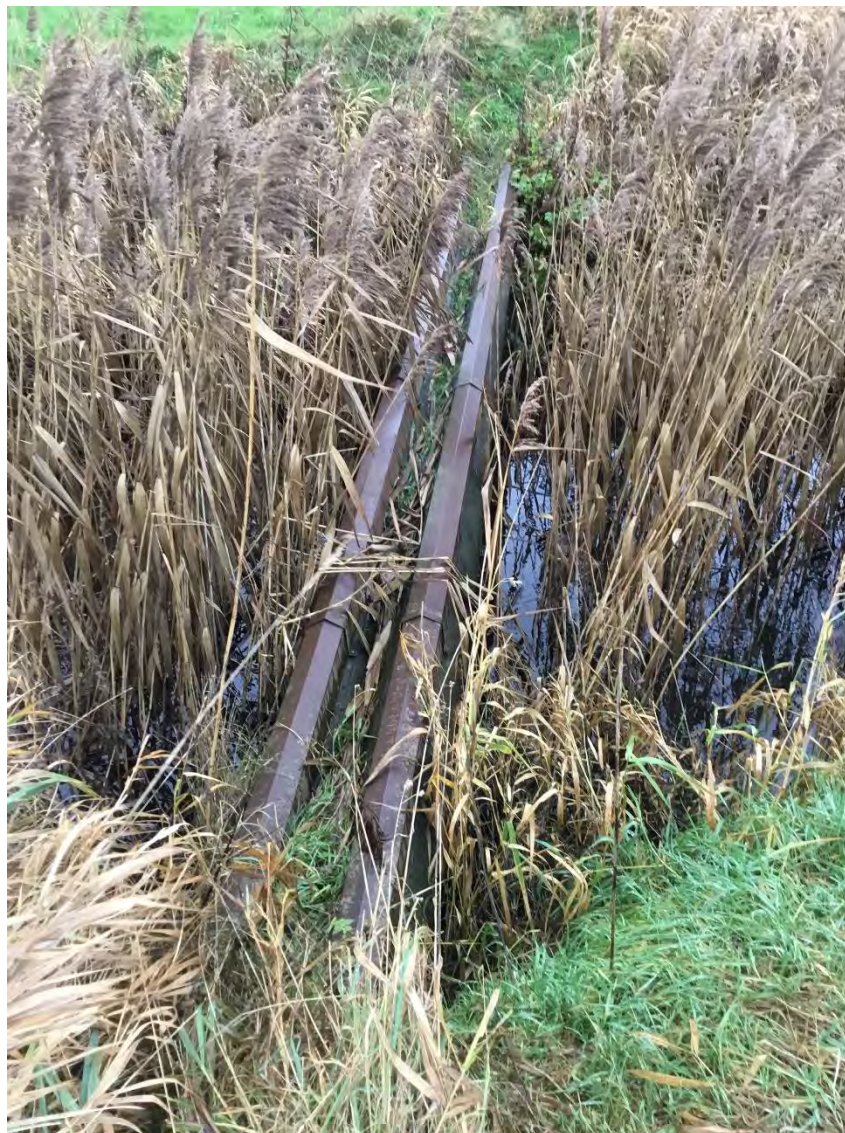
Bild 2: Vattenkorsning i söder: Fjälövsån korsas av två trästolpar med kabelrännor
