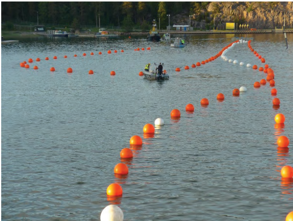
Figur 4 En illustration av metoden float-in där kablarna hålls flytande med bojar.
