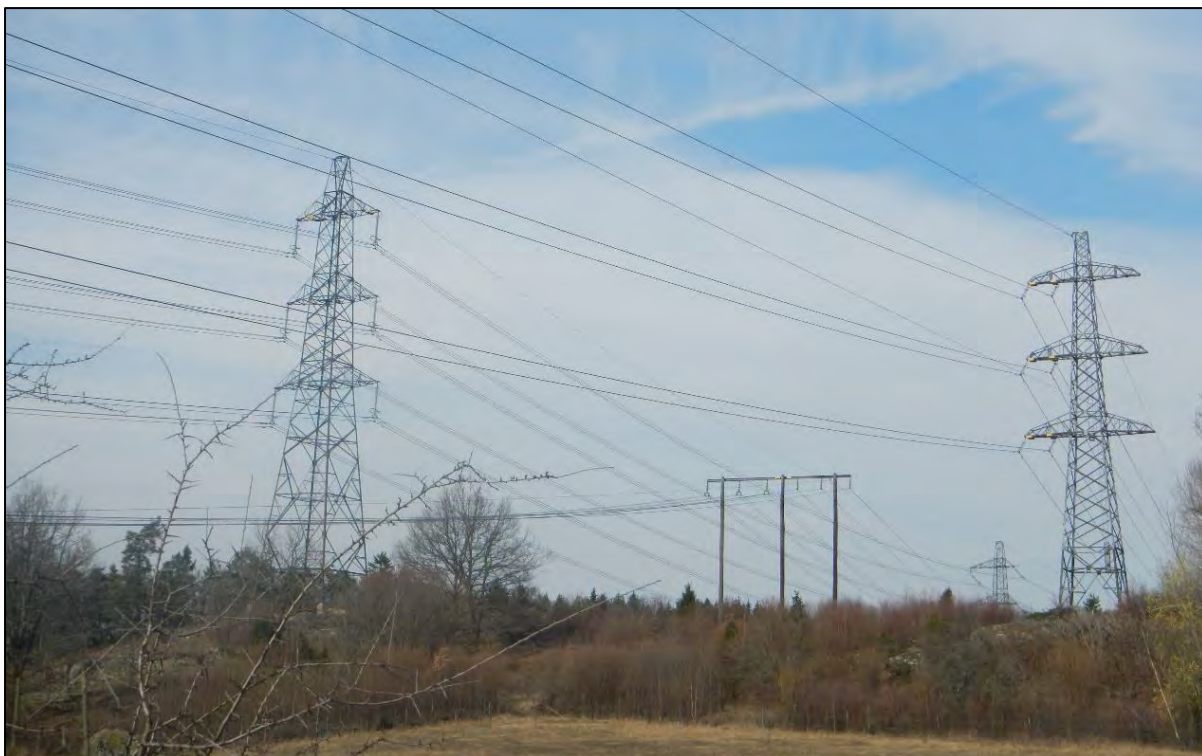
Figur 36. Foto över befintlig ledningsgata där skillnaden mellan stolptyper och stolphöjder tydligt framgår.
