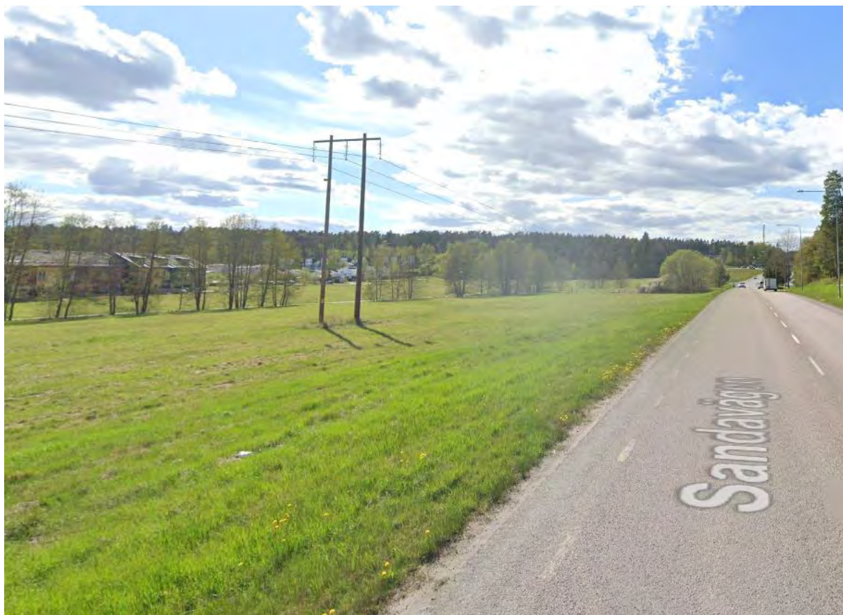
Figur 2. Befintlig kraftledning sedd från Sandavägen, västlig riktning (Källa: Google maps, 2022).
