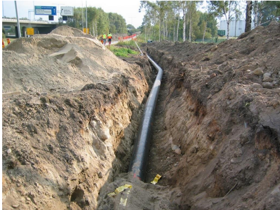
Figur 2. Förläggning av gasrör genom schaktning.
