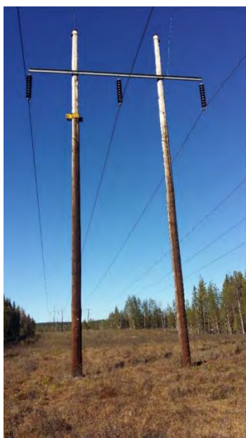
Figur 1. Bilden visar träportalstolpar med 150 kV ledning, likvärdig konstruktion som med aktuell ledning.
