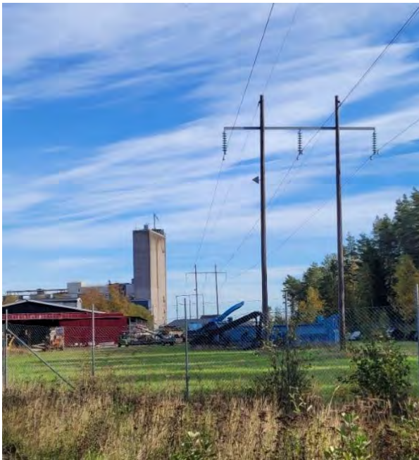
Figur 3. Träportalstolpar tillhörande befintlig ledning L33, direkt öst om det aktuella projektområdet.
