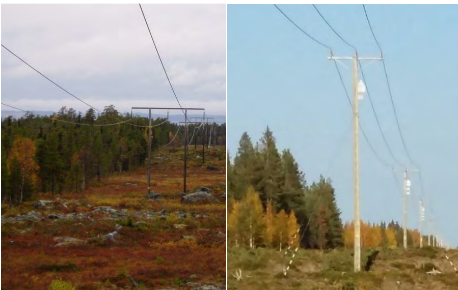
Figur 5. Vänster bild visar ett exempel på portalstolpe. Höger bild visar ett exempel på enkelstolpe.
