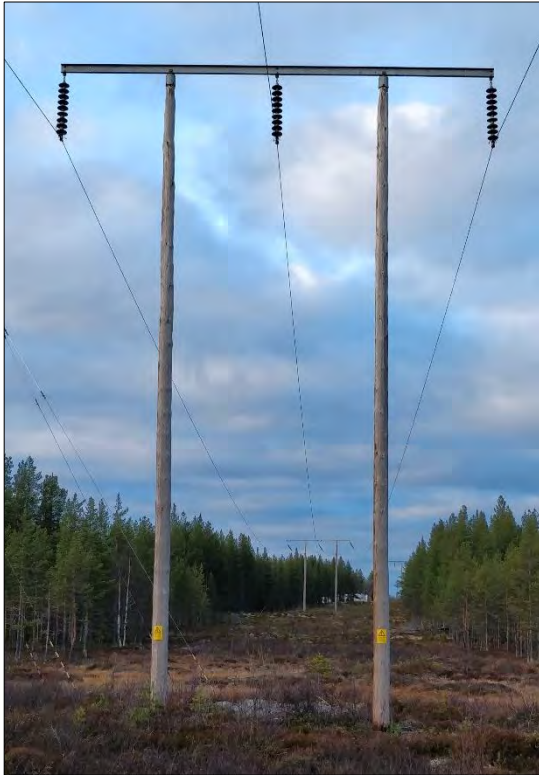
Figur 4-1. Till vänster visas ett exempel på befintlig ledning med tvåbent trästolpe. Till höger visas exempel på enkelstolpar i stål.
